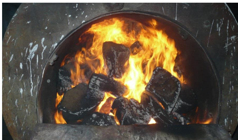
Рис. 2. Рабочий процесс модернизированного котельного агрегата КВ 200 на овечьем кизяке
